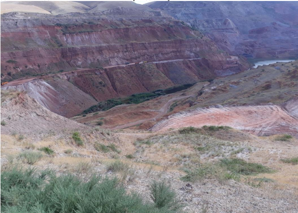
Рис.2. (Фото Туркбаева П.Б. 10. 08. 2017г.) Уступы разреза вскрышных горных работ, требующие соблюдения нормативных углов откоса бортов карьера для недопущения образования оползней и учета возможности защиты от обводнений подземными водами Алмалыкского месторождения углей
