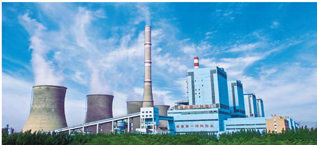
Рис. 3. Электростанция Шенду в Северном Китае.
