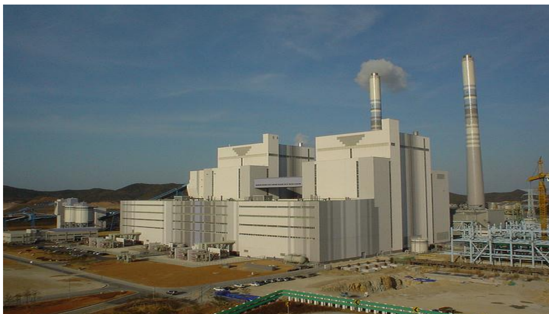
Рис. 4. Общий вид электростанции
